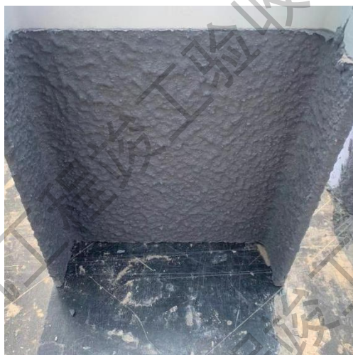
喷涂钢结构防火涂料，厚度应满足不同类型、不同部位的设计要求
