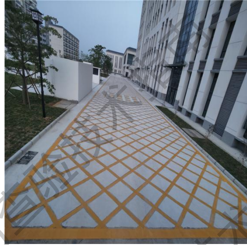
场地与建筑之间不应有进深大于 4m 的裙房及其他妨碍消防车操作的障碍物或影响消防车作业的架空高压电线
