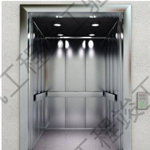
电梯轿厢内部装修材料的燃烧性能应为 A 级
