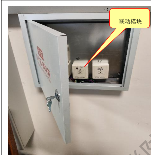
消防联动模块设置在金属箱内
