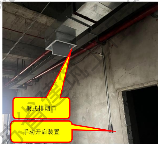
板式排烟口手动开启装置，应安装高度距地面1.3m~1.5m处
