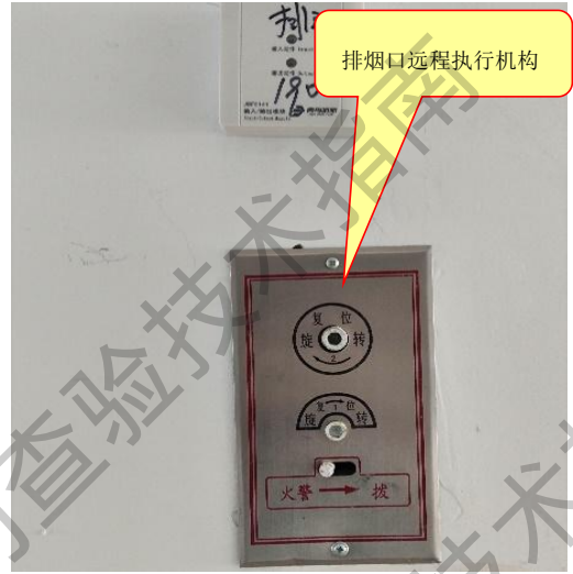
排烟口处远程执行机构及相关联动模块
