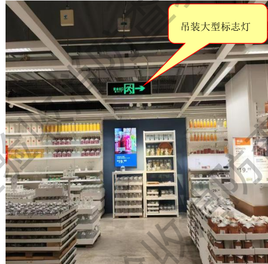
吊装式高度大于 3.5 米大型标志灯
