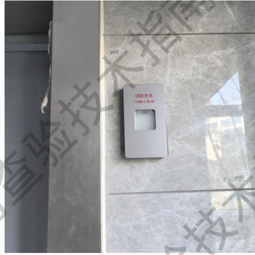
在消防电梯的首层入口处，应设置明显的标识和供消防救援人员专用的操作按钮
