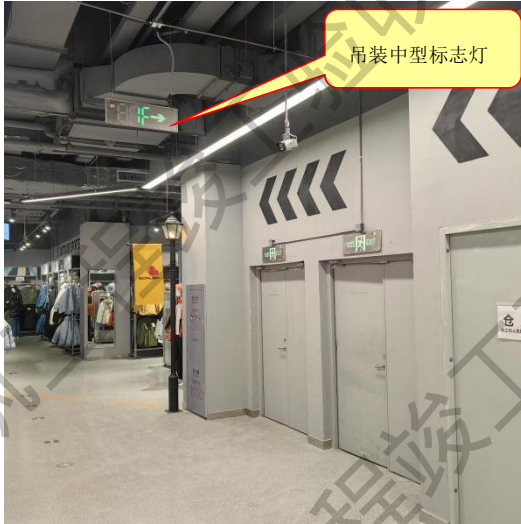
吊装式高度大于 3.5 米中型标志灯
