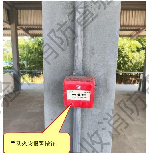
手动火灾报警按钮线路采用金属管保护
