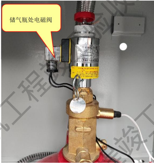
储气瓶处电磁阀不得遗漏
